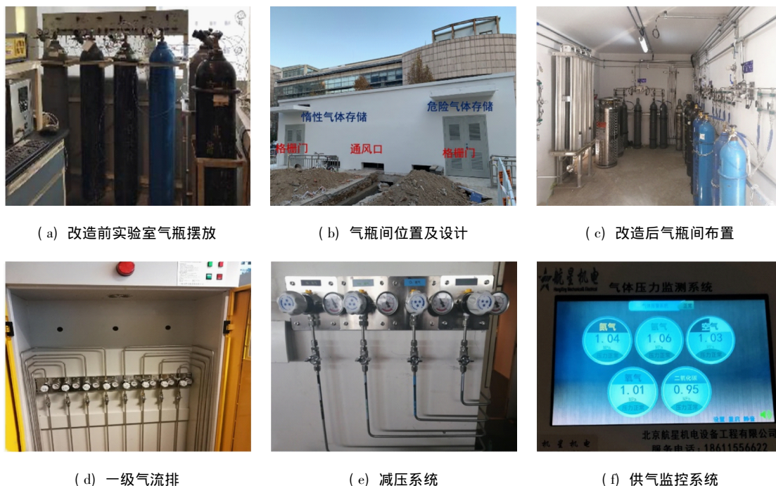
图2 环境学院气路改造工程建设图
